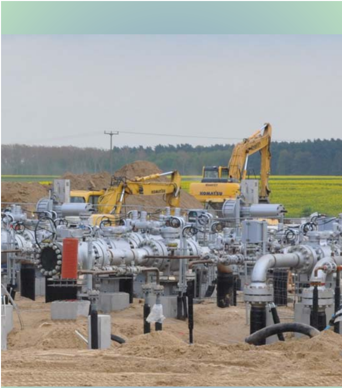
Kugelhähne im Erdgasfeld ball valves in natural gas area
